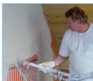
Einlagiges Verputzen heißt preiswert und schnell (je nach Putzhersteller)
