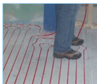
Optimale Rohrführung
