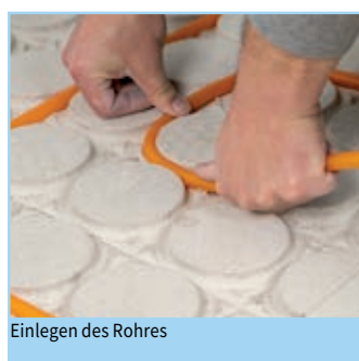
Optimale Rohrführung
