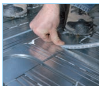
Einlegen des Rohres
