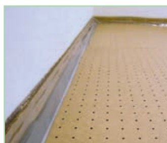
bavaria hp praski Biofaserlochplatte® auf Estrichfolie und Trittschalldämmung
