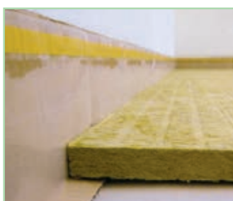
Mineralische Trittschalldämmung mit Öko-Randdämmstreifen*
