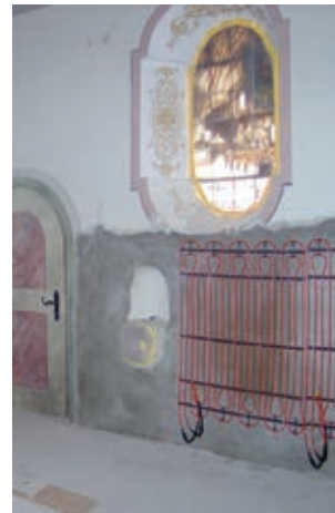
Vorher: Kirchenrenovierung mit NWF 8 Wandsystem Hochleistungsmodul
