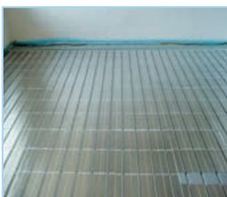
Vollflächiges Aluminiumleitblech
