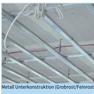
Metall Unterkonstruktion (Grobrost/Feinrost)
