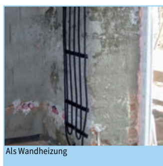
P70 Rohr 10 x 1,3 mit Schutzrohr
