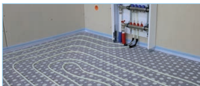
Rohr mit Klettbefestigung
