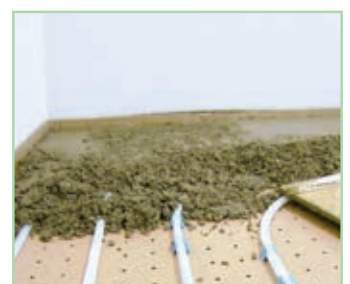
Einbringen des Estriches
