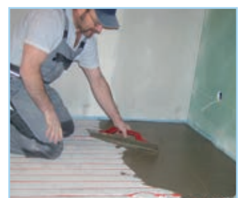
Auftragen des Fliesenklebers
