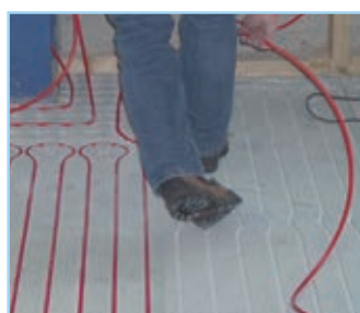
Einlegen der Heiz-/Kühlrohre
