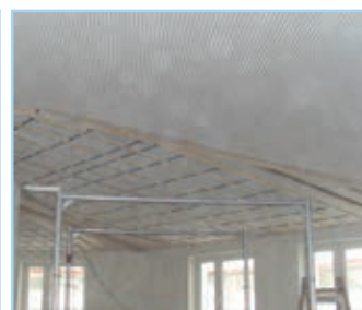
Sandwichdecke mit fertiger Decke im Vordergrund
