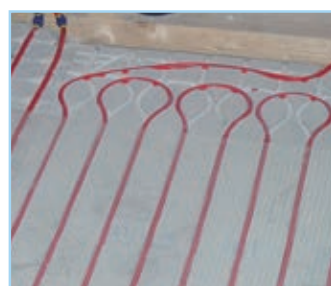
Zeitsparende Verlegung in vorgefräste Platten
