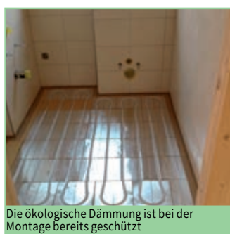
Vollflächiges Aluminiumleitblech
