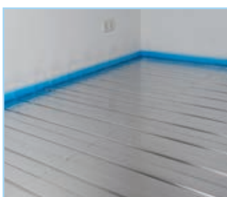
Vollflächige Aluminiumbeschichtung
