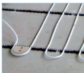
Einlegen der Rohre
