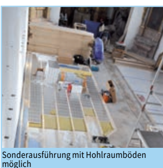
Vollflächiges Aluminiumleitblech
