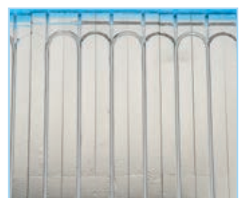
Verlegte Fläche mit Rohrleitungen
