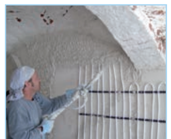
Einlagiges Verputzen heißt preiswert und schnell (je nach Putzhersteller)
