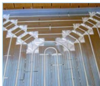
Schneckenverlegung: sorgt für gleichmäßige Leistungsverteilung
