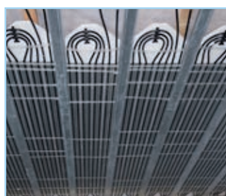
Montiertes System vor der Beplankung
