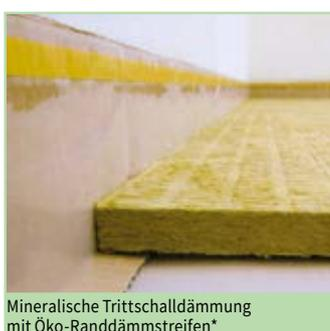
Mineralische Trittschalldämmung mit Öko-Randdämmstreifen\*
