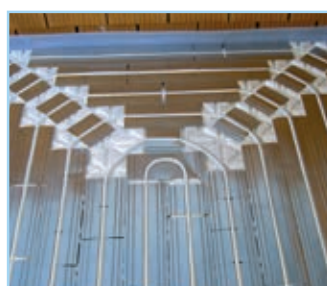
Schneckenverlegung: sorgt für gleichmäßige Leistungsverteilung
