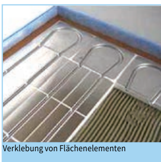
Rohrverlegung
