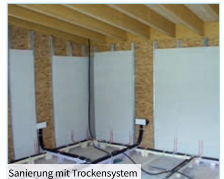
Sanierung mit Trockensystem
