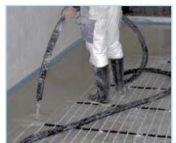
Einbringen des Nivellierestrich bzw. Ausgleichsmasse
