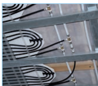
Anschluss der Module
