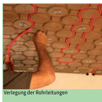
Fertige Rohrverlegung
