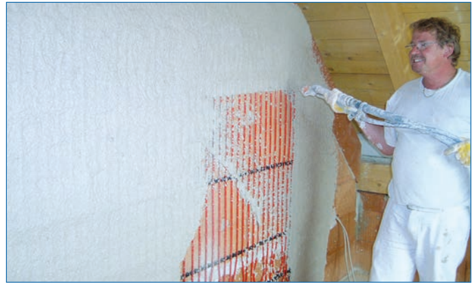
Wandverputz aus Gips
