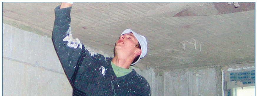
Verputzen einer Deckenheizung/Kühlung
