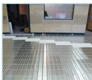
Verlegung der Systemdämmplatte mit Wärmeleitblech
